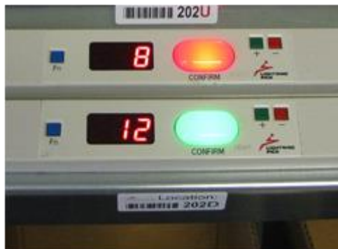
ก) อุปกรณ์ไฟฟ้า
