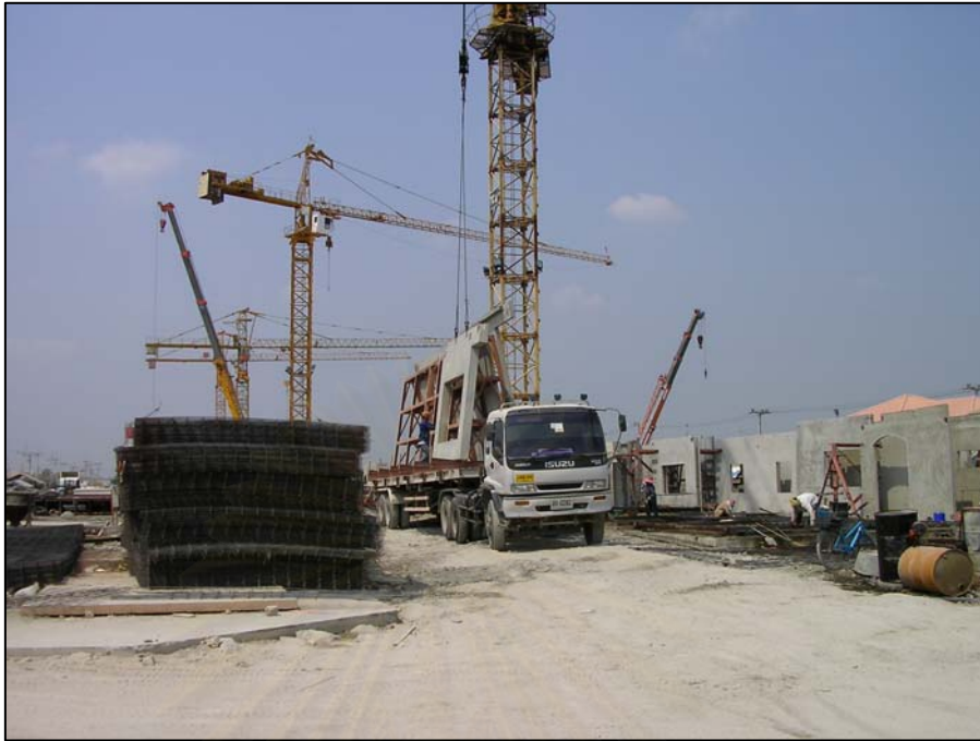
รูปที่ 4.9 การขนส่งชิ้นส่วนคอนกรีตสำเร็จรูปของหน่วยงานลานผลิต
