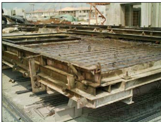
รูปที่ 4.3 แบบหล่อที่เป็นลักษณะ โต๊ะหล่อ
