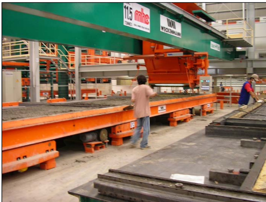
รูปที่ 4.6 การทำงานขั้นตอนการเทคอนกรีตของโรงงานผลิต
