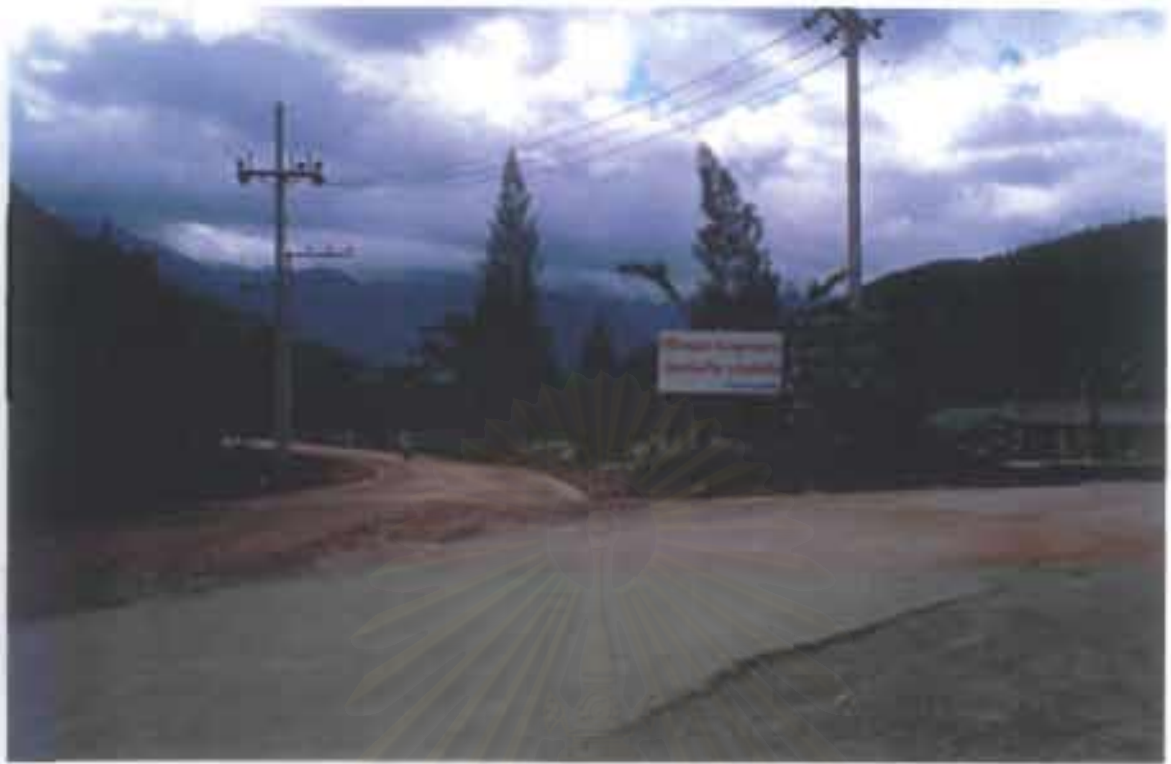
ภาพที่ 3-18 แสดง สถานีรูปโกล (ไฟฟ้า) ที่วัดทุกขลังศาเมือง โดยการไฟฟ้าส่วนภูมิภาค
