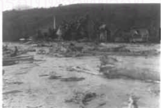
▶ ภาพที่ 3-5 แสดง สภาพความเสียหาย ทั่วไปในชุมชนศิริวง ภายหลังจากน้ำลด
