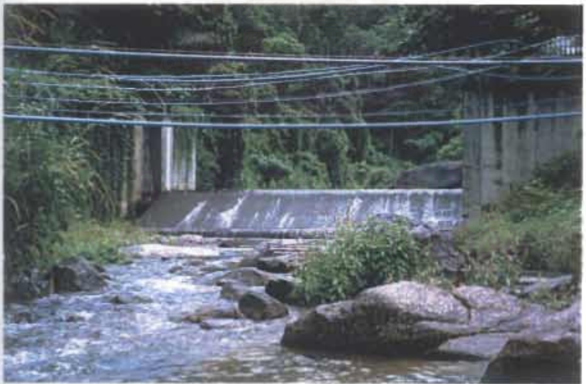
ภาพที่ 3-19 แสดง ระบบประปาของชุมชน ซึ่งเป็นประปาภูเขา ใช้วิธีสร้างฝายกั้นเก็บกักน้ำจากแหล่งน้ำตามธรรมชาติ (ลำคลอง) แล้วแจกจ่ายไปให้ชุมชน
