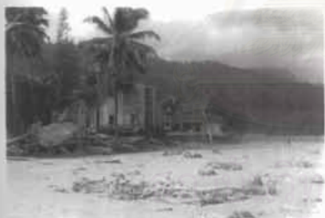
◀ ภาพที่ 3-4 แสดง สภาพความเสียหาย บริเวณวัดศิริวง ภายหลังจาก น้ำลด
