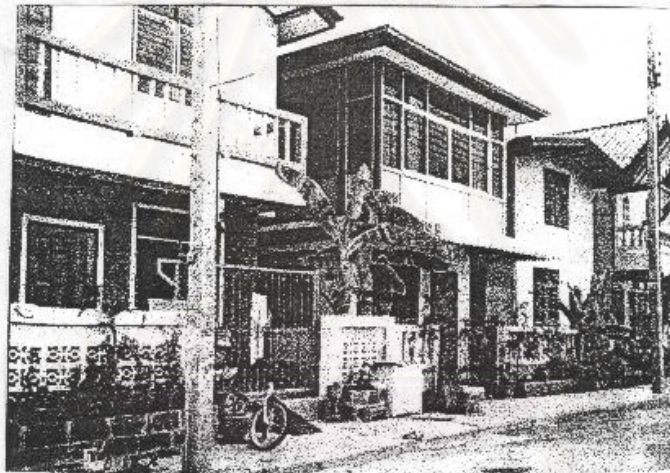
แสดงภาพบ้านที่สร้างถาวรตัวชุมชนวิชรพล 3 โดยสร้าง เป็นบ้านสองชั้น ใช้วัสดุทั้งเก่าและใหม่ ส่วนรวมใช้เป็นวัสดุอย่างดี
