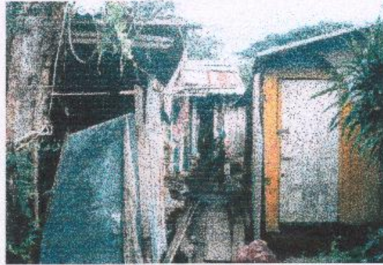
ภาพที่ 5.5 แสดงการใช้วัสดุสร้างบ้าน ที่ใช้ภายในชุมชน มีการใช้ไม้เป็นส่วนใหญ่ไม่ว่าจะเป็นผนังที่แป้นไม้ ส่วนทางเดินที่เข้าไปอีกภายในจะใช้ไม้ยกขึ้นมา
