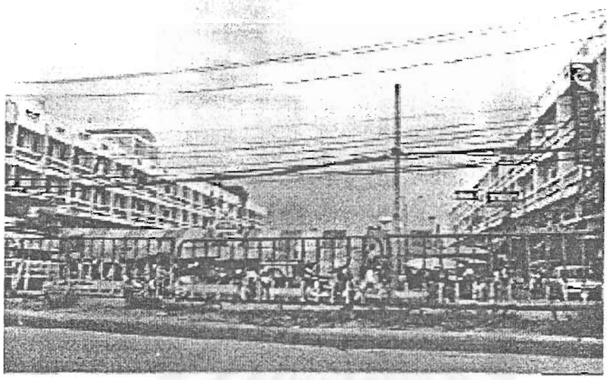
ภาพที่ 3.3 แสดงอาคารบริเวณตรงข้ามนิคม มีการใช้งานเฉพาะชั้นล่าง
